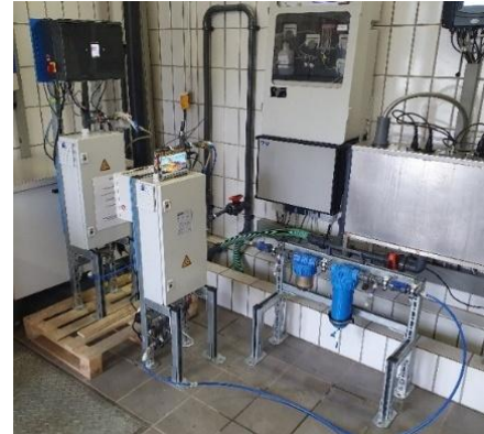
Pilotaufbau an der Kläranlage
