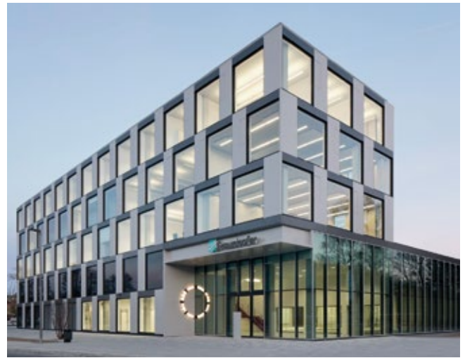
Das neue Gebäude der Fraunhofer-Projektgruppe Prozessinnovation
